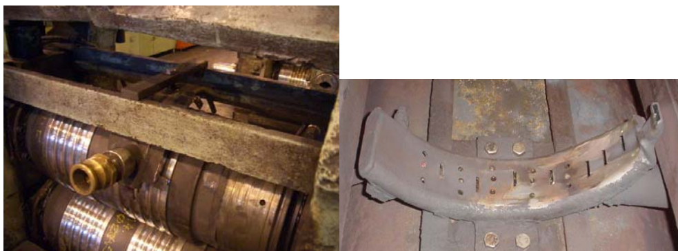
Figura 14 – Cintas de refrigeração com fixação por parafusos M19
