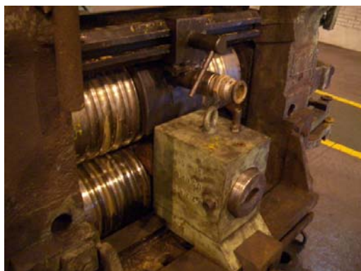
Figura 16 – Projeto instalado nas gaiolas do trem intermediário
