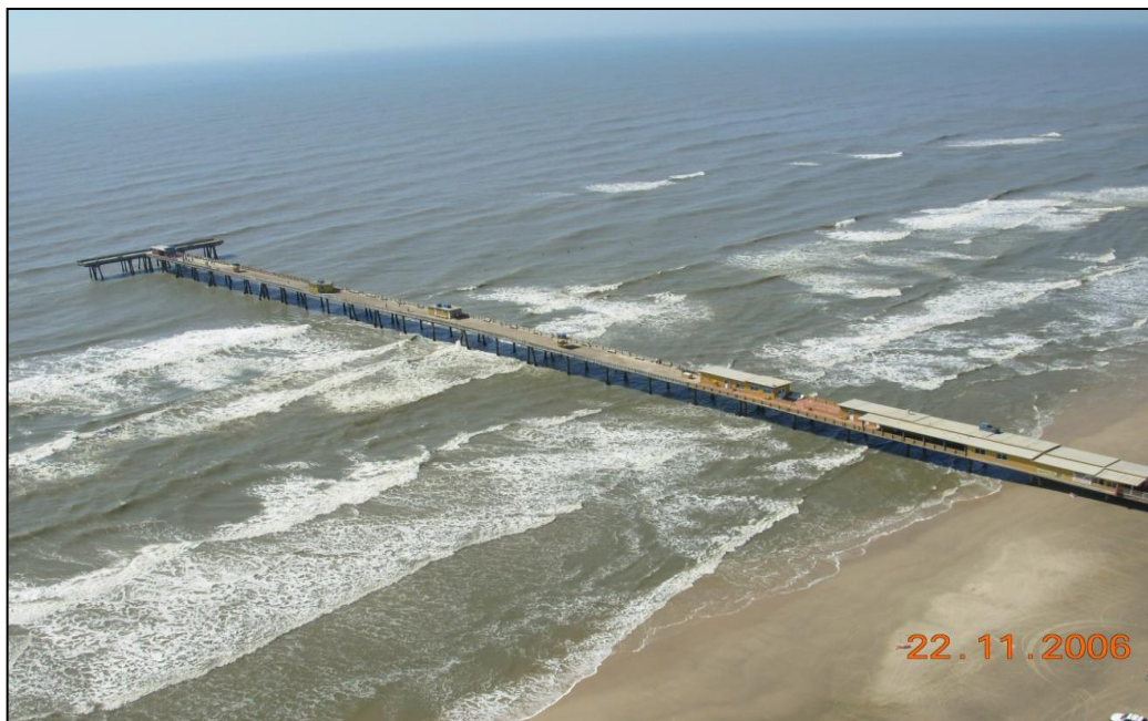
Figura 1. Vista aérea da plataforma de pesca de Tramandaí. Fonte: Marcelo Gerin.
