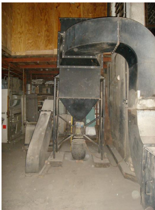
Figura 5 – Filtro multiciclone.
