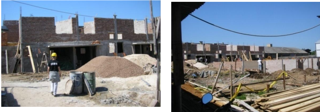
Figura 5.13 Cooperativa COVIAM 96 ( vista octubre 2010/ obra en ejecución)
