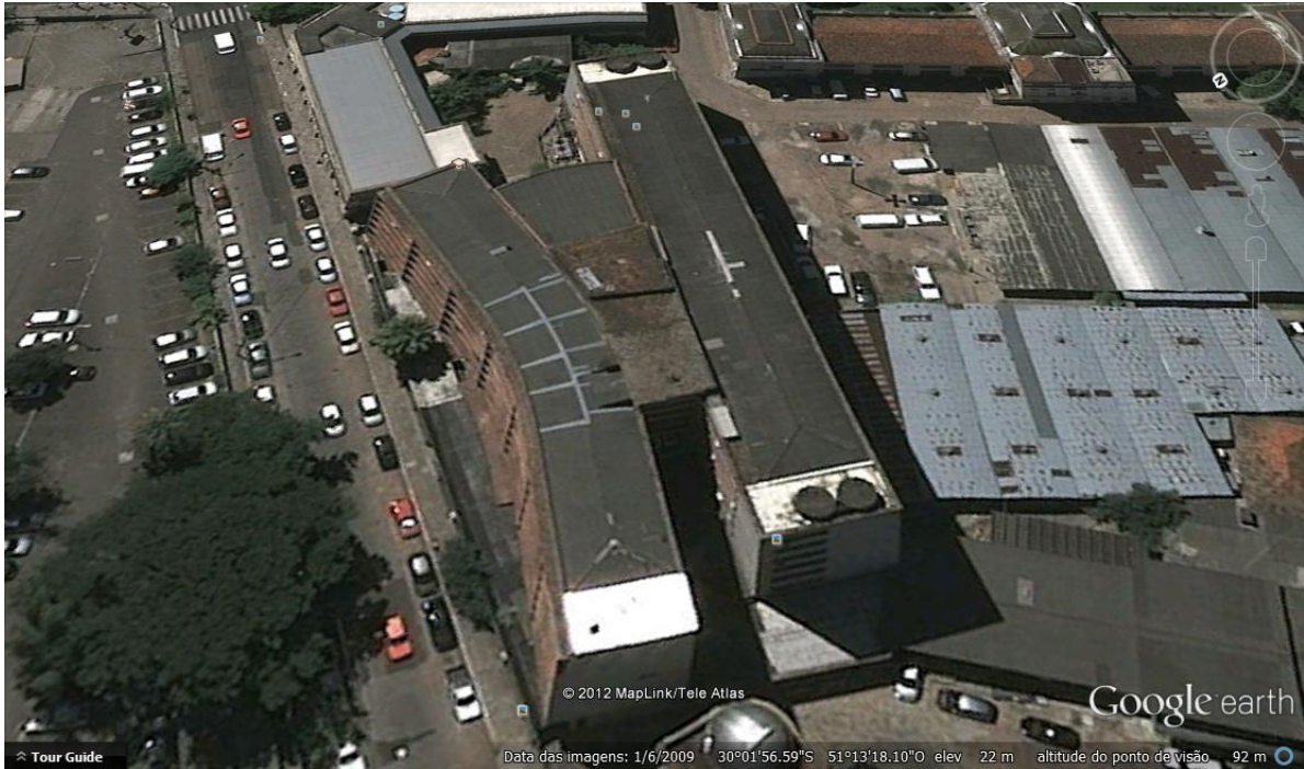
Apêndice I - Imagem aérea do local escolhido para instalação da microturbina eólica
