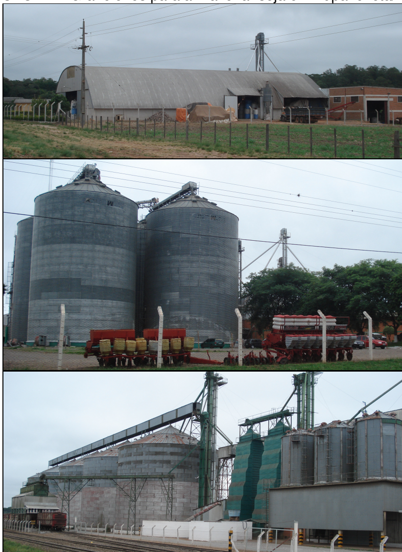
FOTO 17 – Graneleiros para armazenar soja em Tupanciretã/RS
