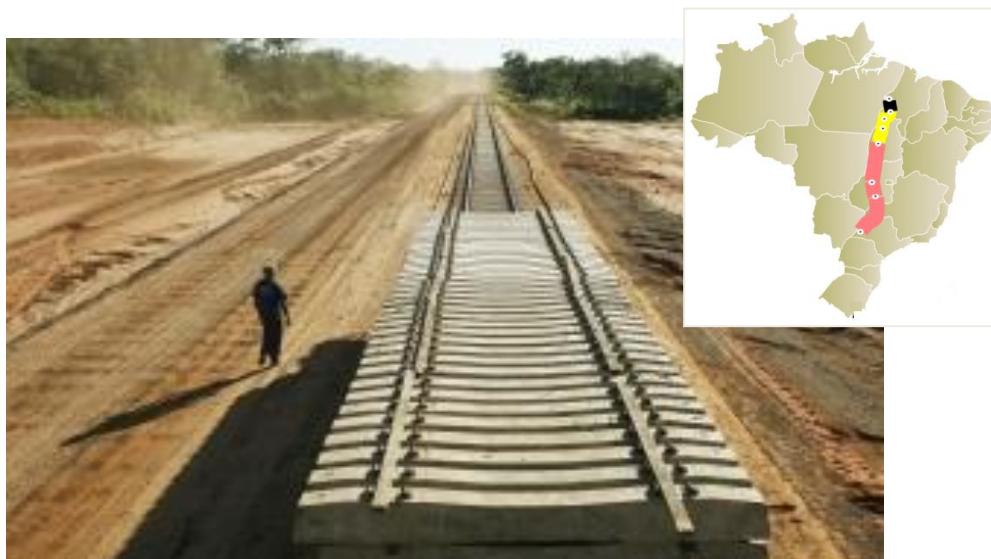
Figura 10 – Construção da Ferrovia Norte-Sul (TO/GO/MG/SP)
