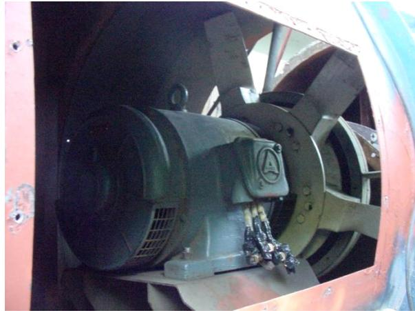
Figura 4: motor ARNO de 100Hp instalado no interior do túnel. Acionamento: chave Y - Δ.
