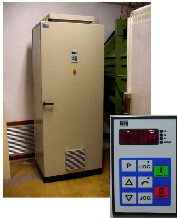
Figura 9: inversor de frequência e detalhe de sua IHM.
