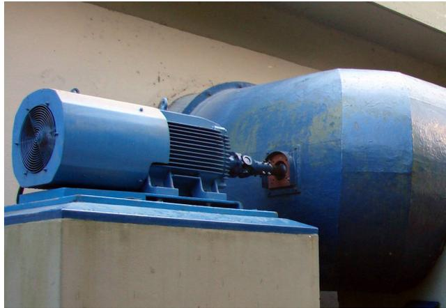
Figura 6: motor instalado fora do túnel e aciona a hélice por meio de um eixo.
