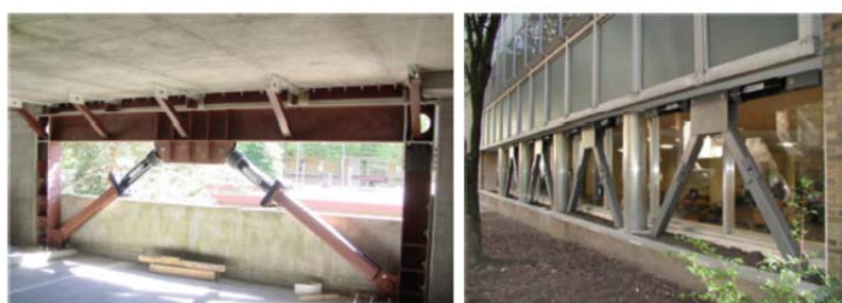
Figura 3.2: Amortecedor viscoso instalado na Portland State University.
