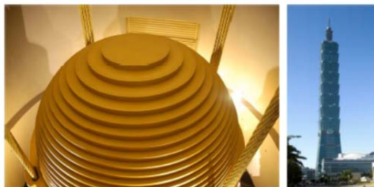
Figura 3.1: TMD do Taipei 101 e o respectivo edifício.
