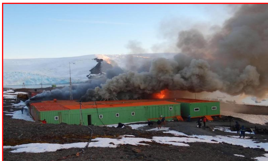
Fotografia 21: O incêndio que destruiu quase toda a infraestrutura da EACF.
