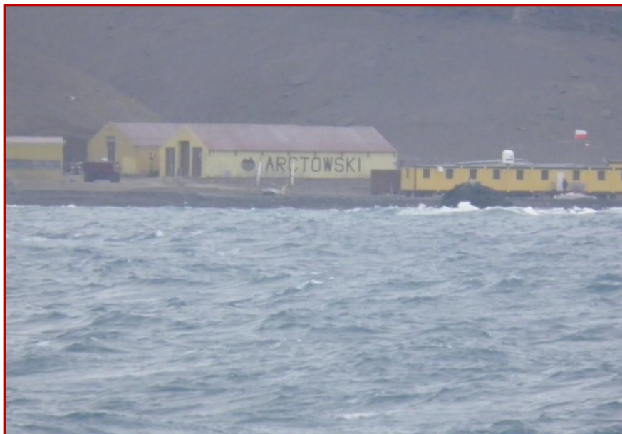
Fotografia 5: Estação Antártica Polonesa Arctowski. Fonte: Autor – Operação Antártica XXIX (2010-2011).
