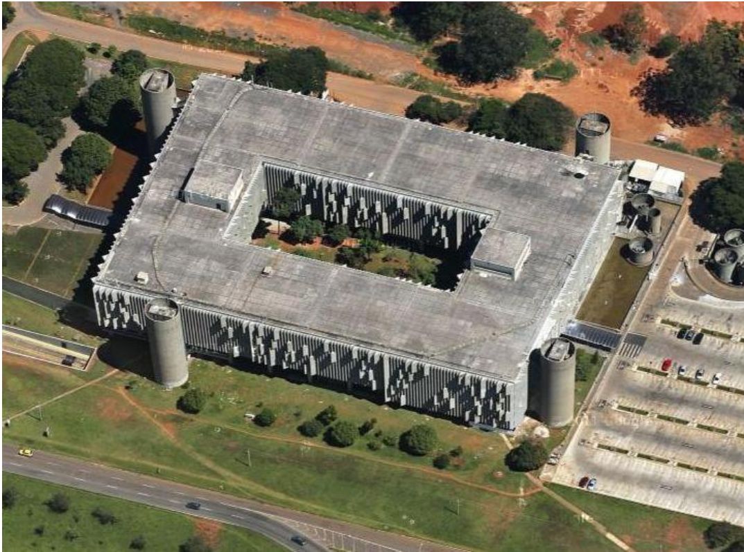
Figura 2 – Imagem de satélite do edifício-sede do DNIT (Brasília, 2012)
