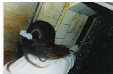
FIGURA 6 – Coleta de amostra de biofilme no Reservatório de Azulejo do HCPA.
