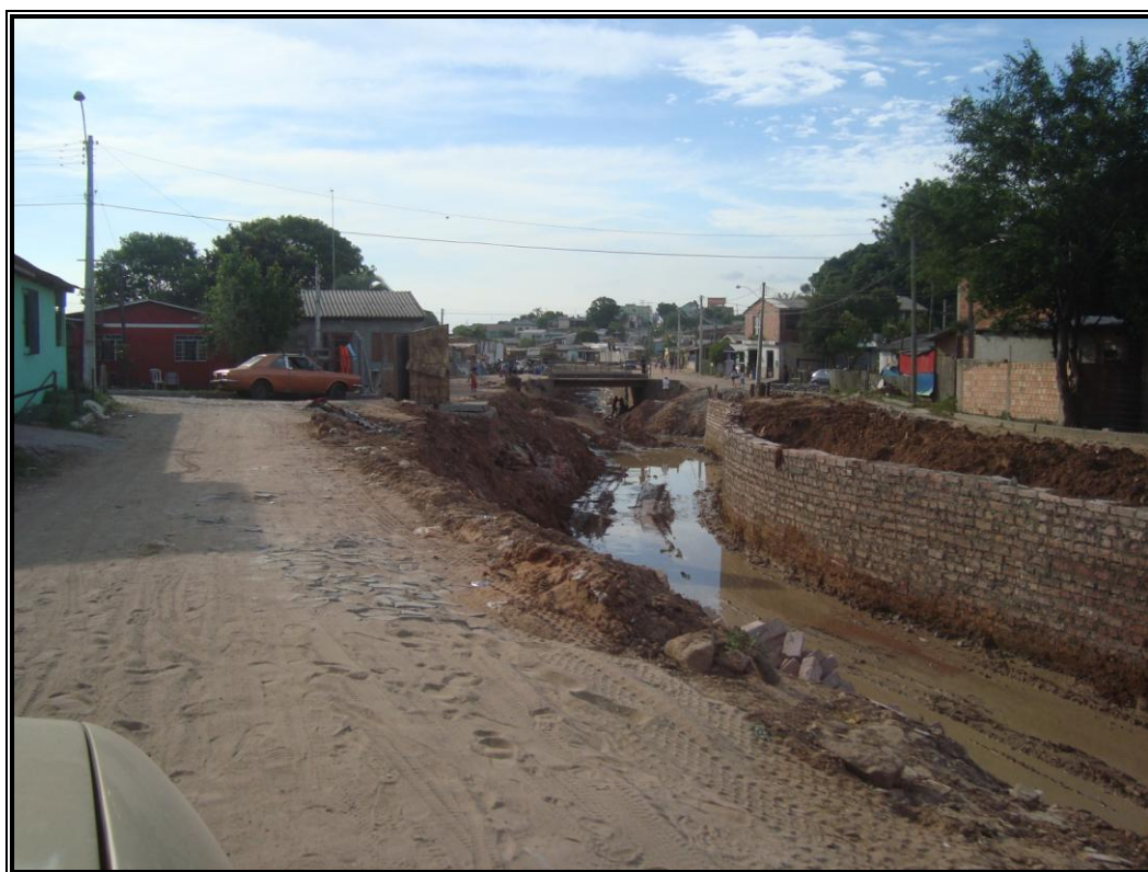
Fotografia 1 - Arroio José Joaquim numa região mais próxima à sua nascente. Conforme é possível visualizar, está recebendo obras de canalização, com a justificativa de conter os alagamentos (novembro/2012).
