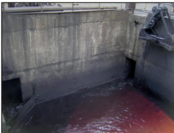
Figura 9 – Poço de acumulação e coleta de carepa do LC.
