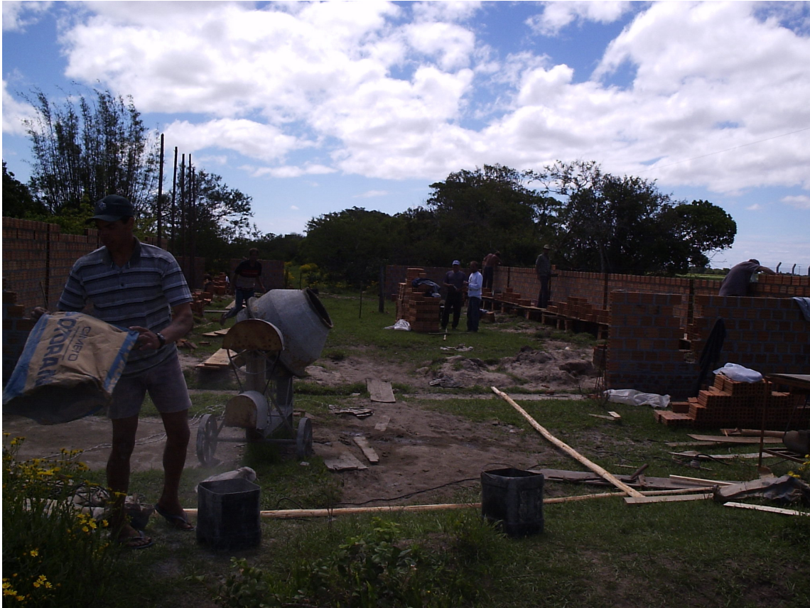
Foto 6: Mutirão na comunidade do Capão do Meio para construção de galpão coletivo.
