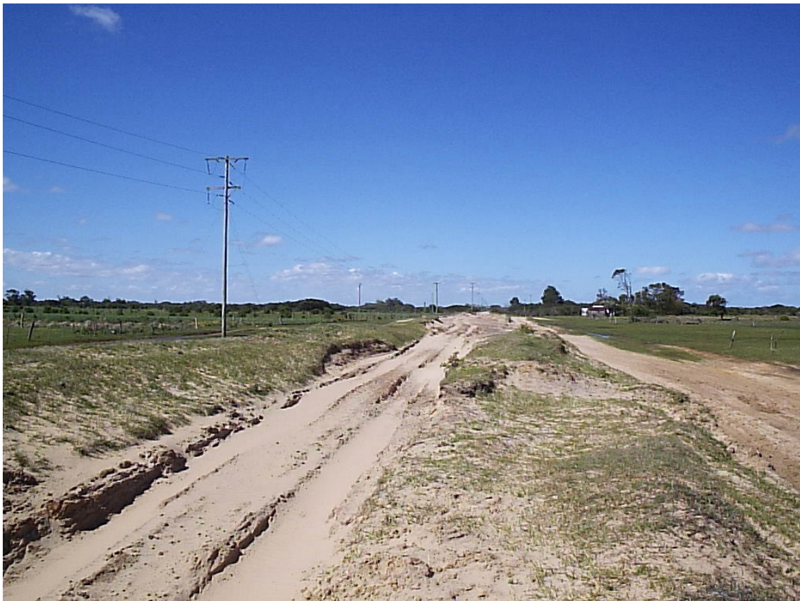
Foto 4: Condições do Trecho da BR 101 ainda não pavimentado.
