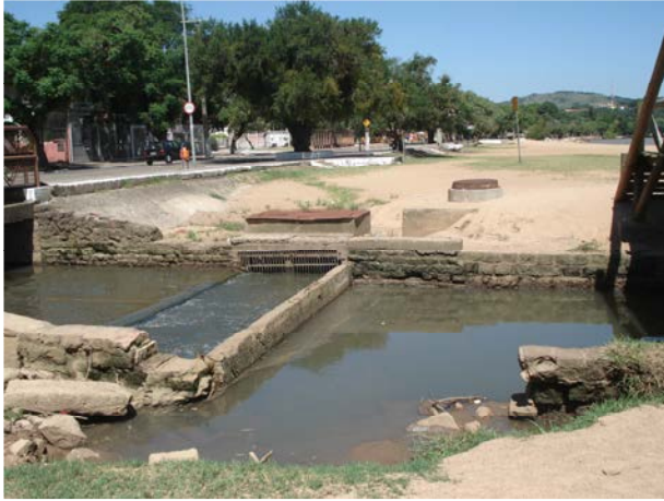
Figura 4.26 - Interceptor arroio Capivara Trabalho de campo: 09-02-2010.
