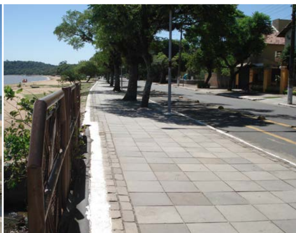
Figura 4.30 - Impermeabilização do solo, junto a foz da bacia hidrográfica do arroio Capivara Trabalho de Campo: 09-02-2010.
