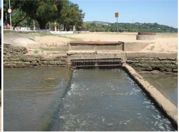
Figura 4.27 - Interceptor arroio Capivara Trabalho de campo: 09-02-2010.
