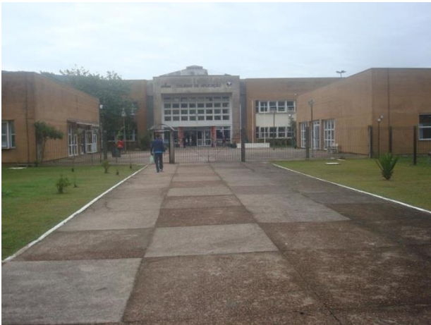
Figura 2-Foto da entrada principal do CAp-UFRGS
