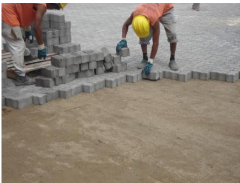
Figura 15 – Execução do assentamento dos blocos
