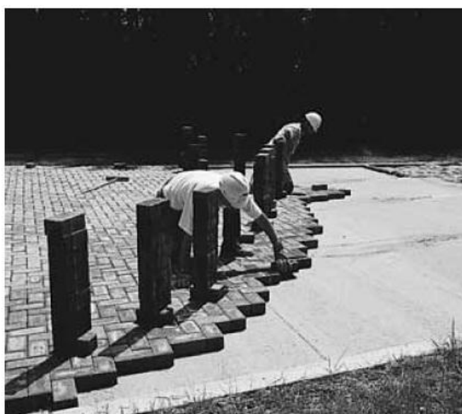
Figura 5 – Assentamento dos blocos
