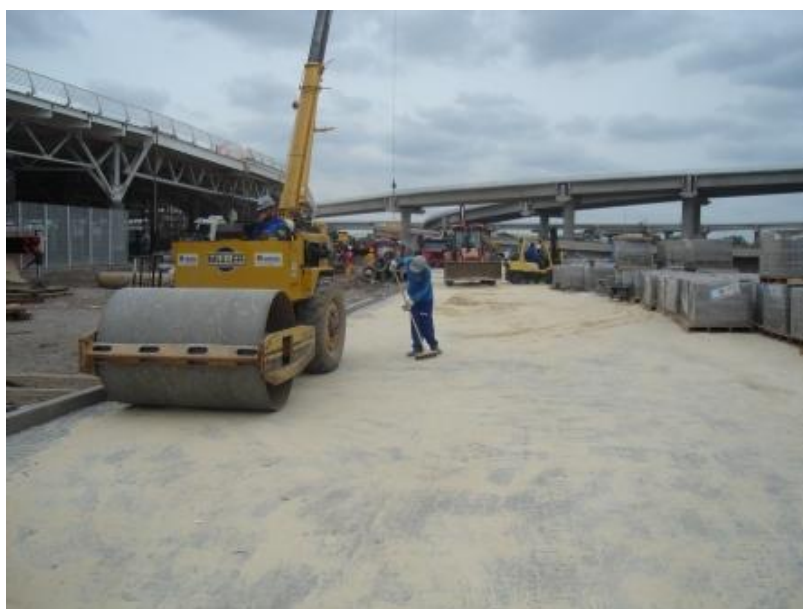
Figura 20 – Execução da compactação final
