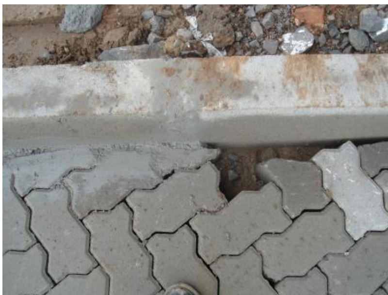
Figura 17 – Acabamento junto ao meio-fio
