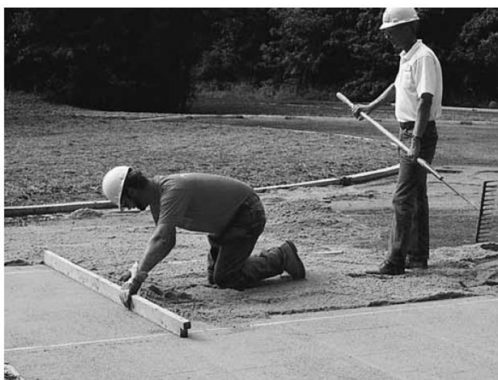
Figura 4 – Nivelamento da areia de assentamento
