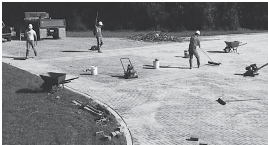
Figura 7 – Espalhamento e varrição da areia de rejuntamento
