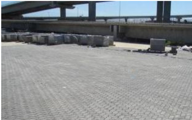
Figura 11 – Depósito dos blocos de concreto
