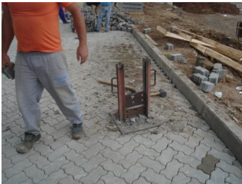
Figura 16 – Guilhotina para corte dos blocos
