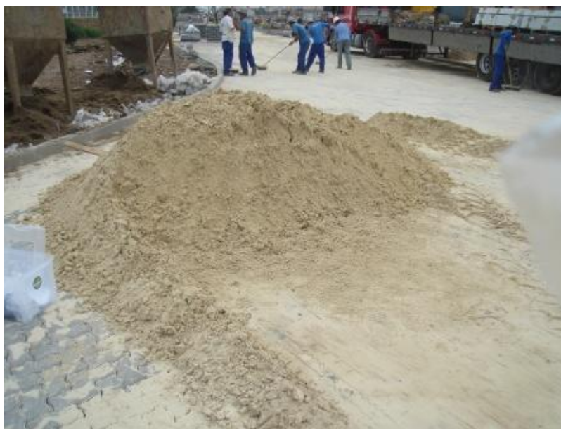
Figura 12 – Depósito da areia de rejuntamento
