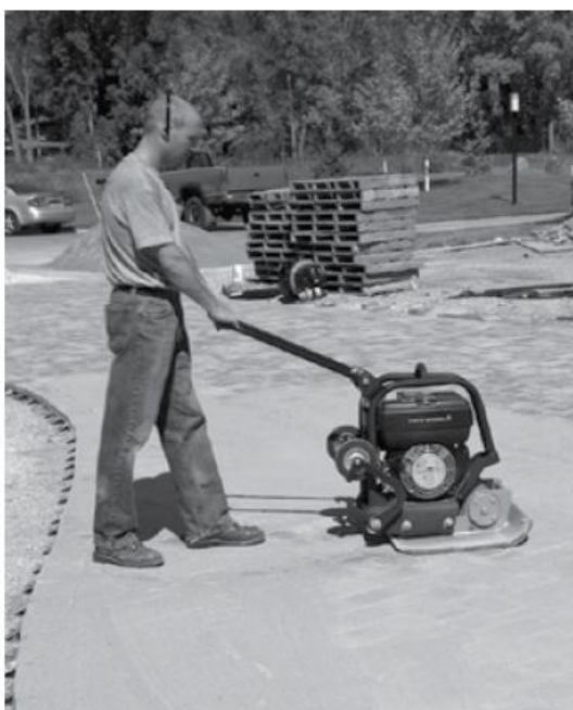
Figura 8 – Compactação final dos blocos
