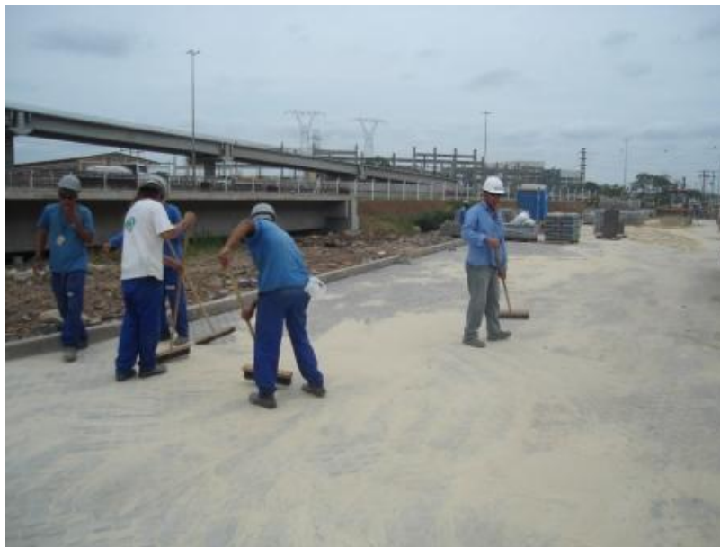
Figura 19 – Espalhamento e varrição da areia de rejuntamento em campo
