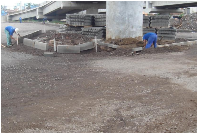
Figura 13 – Execução das contenções laterais
