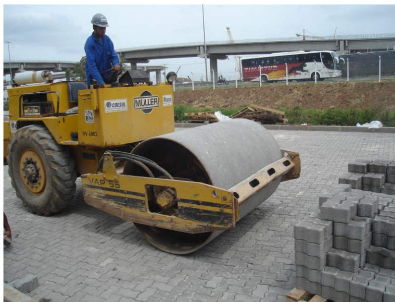
Figura 18 – Execução da compactação inicial
