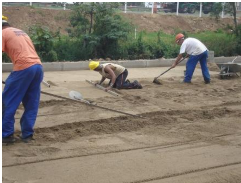
Figura 14 – Espalhamento e nivelamento da areia de assentamento em campo
