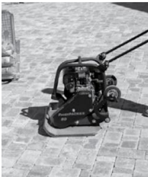
Figura 6 – Compactação inicial dos blocos
