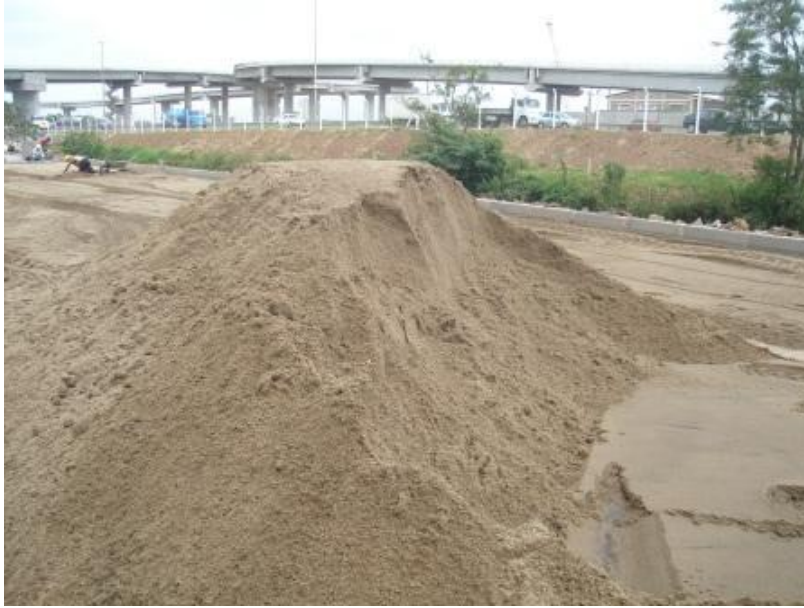
Figura 10 – Depósito da areia de assentamento
