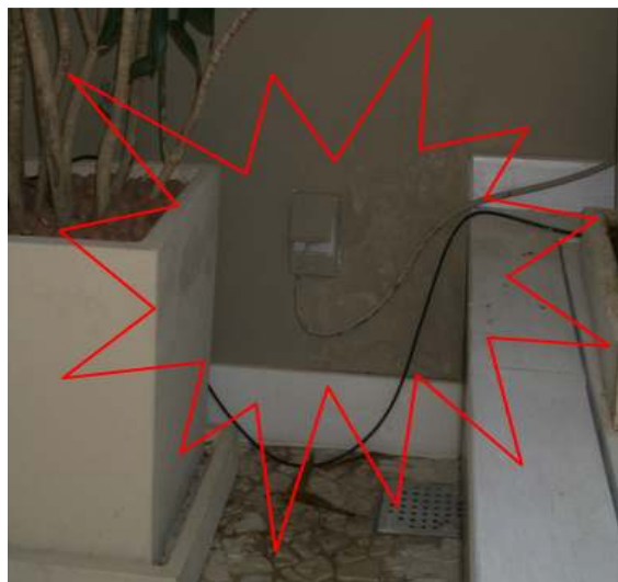
Figura 80 – Mancha de umidade e danificação da pintura devido à infiltração
