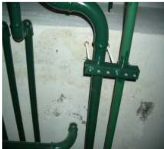
Figura 78 – Mancha de umidade causada por impermeabilização mal executada em laje de piscina
