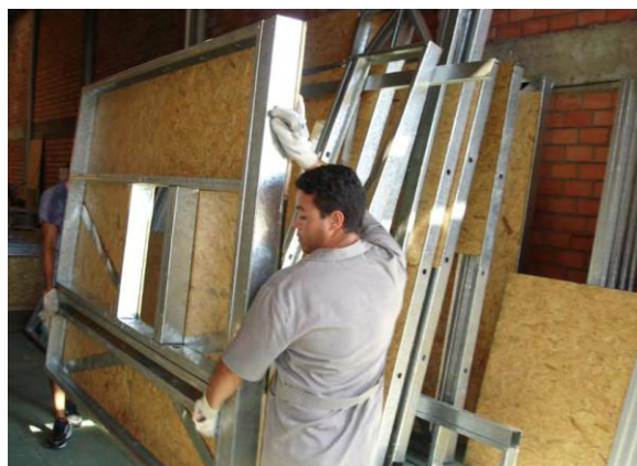
Figura 5 – Montagem dos painéis
