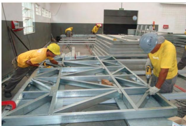
Figura 4– Montagem dos perfis estruturais
