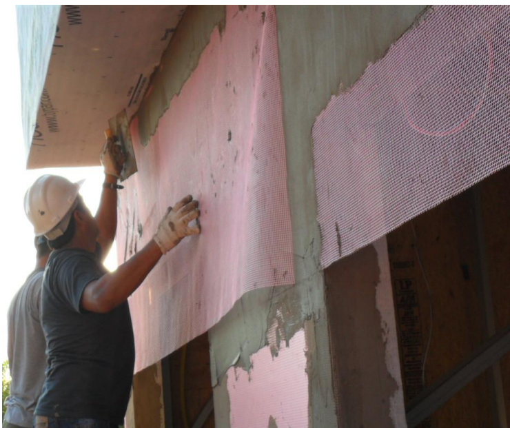
Figura 30 – Aplicação de argamassa sobre tela
