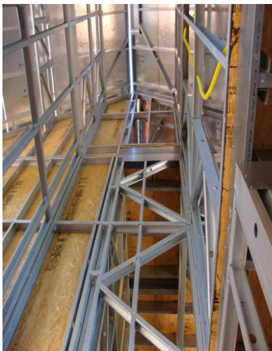
Figura 24 – Contraventamento em diagonal
