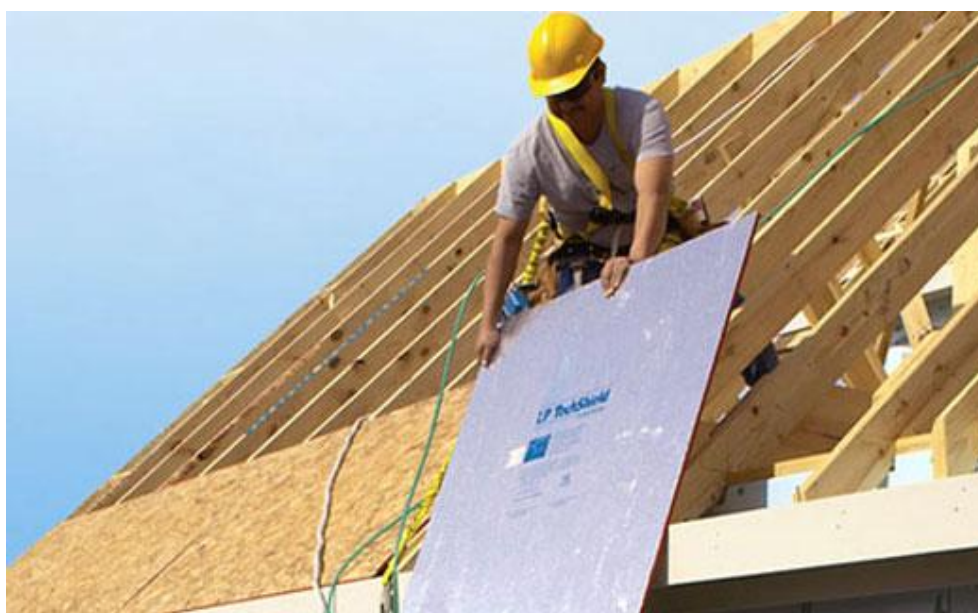
Figura 26 – Colocação de cobertura tipo shingle isolada
