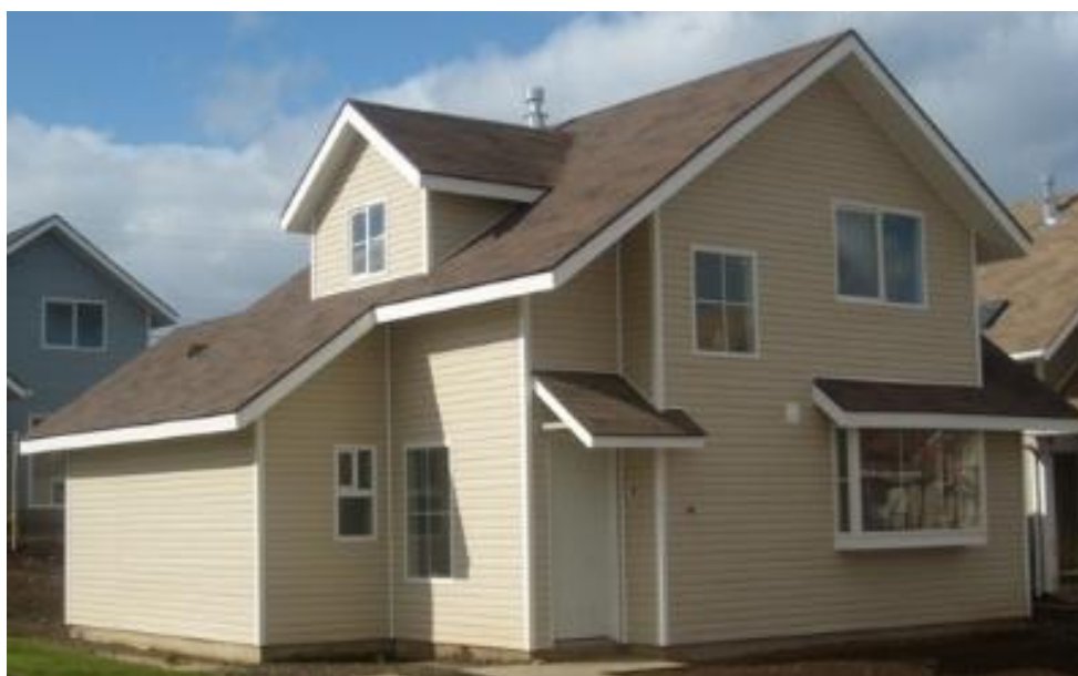
Figura 14 – Edificação com siding vinílico
