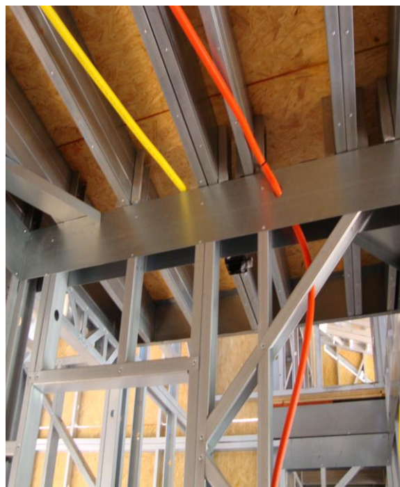
Figura 25 – Reforço com fita metálica
