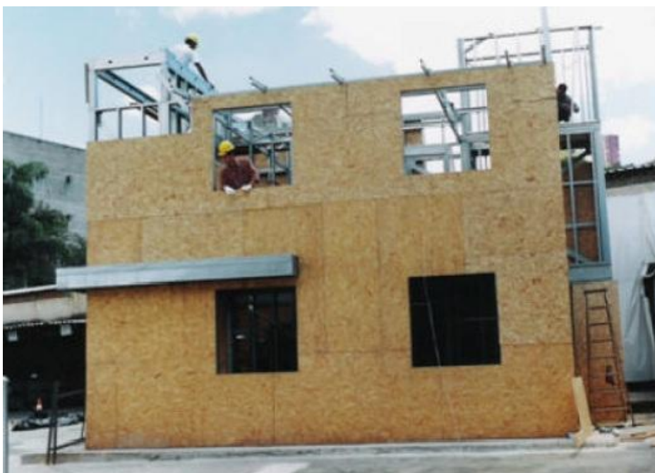
Figura 10 – Fechamento externo com placas OSB
