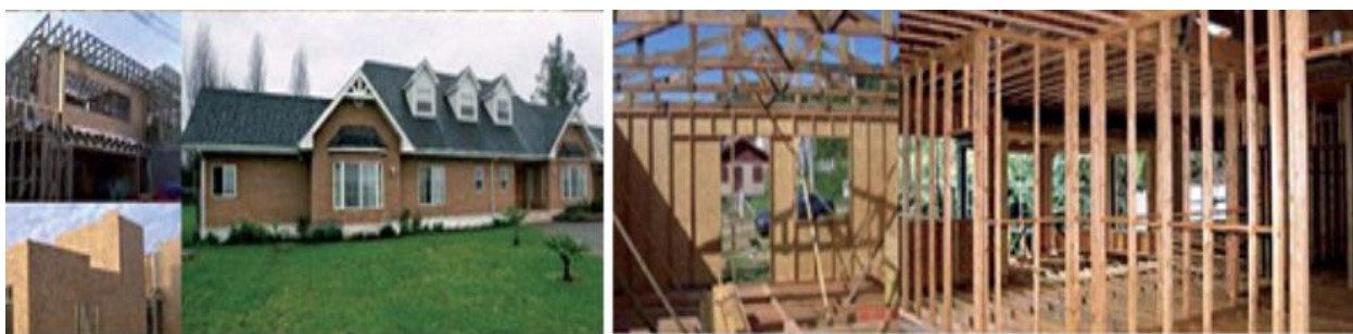
Figura 3 – Estruturas executadas em Wood Framing
