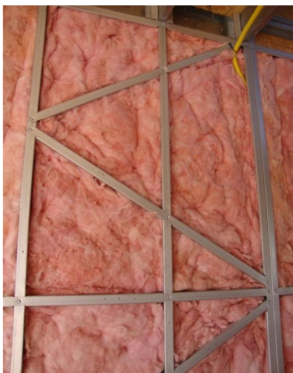
Figura 16 – Inserção de lã mineral entre perfis no LSF
