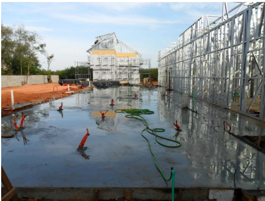
Figura 7 – Fundação em radier em edificação de Steel Frame
