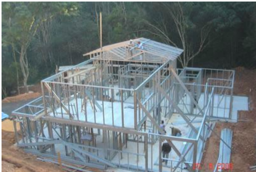
Figura 2 – Estrutura em Light Steel Frame
