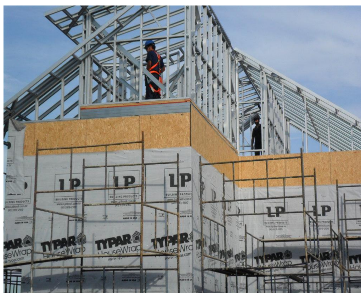
Figura 29 – Manta hidrófuga sobre placa OSB
