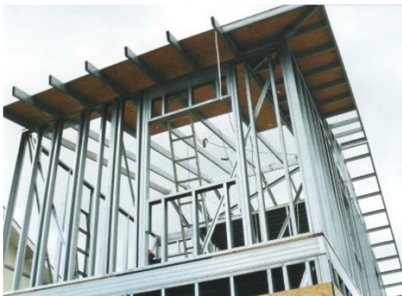
Figura 13 – Apoio de OSB para telhamento do tipo Shingle
