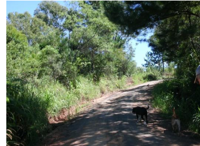
Estrada de acesso local
