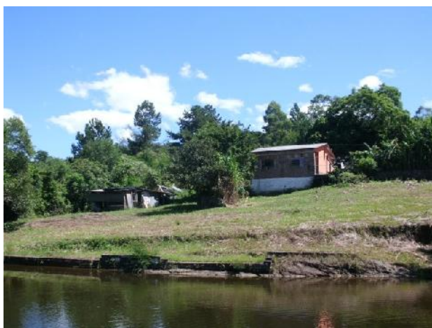
Vista da casa existente
