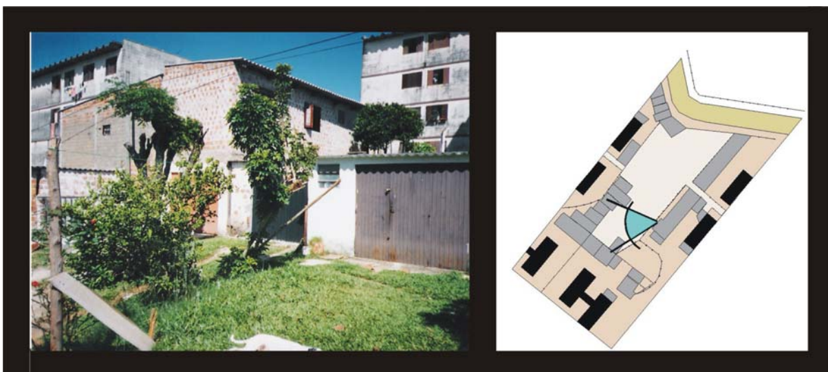
Figura 79 Construções junto à Praça 2. Garagem sofreu aumento vertical, com residência no segundo pavimento.
