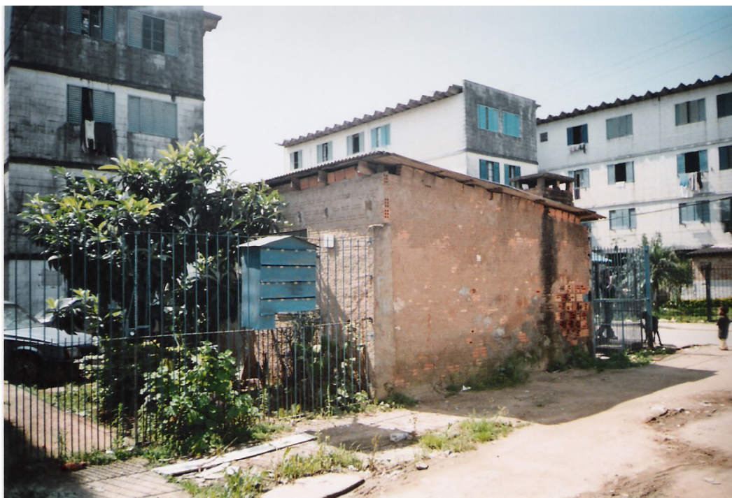
Figura 138 Harmonia formal entre célula elementar e blocos: volumes simples, coberturas em fibrocimento com pouca inclinação.
