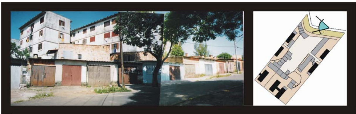
Figura 78 Conjunto de garagens junto à Rua D. Garagens do Núcleo 1, a oeste da Praça 2. Atrás das garagens, casas e extensões dos blocos
