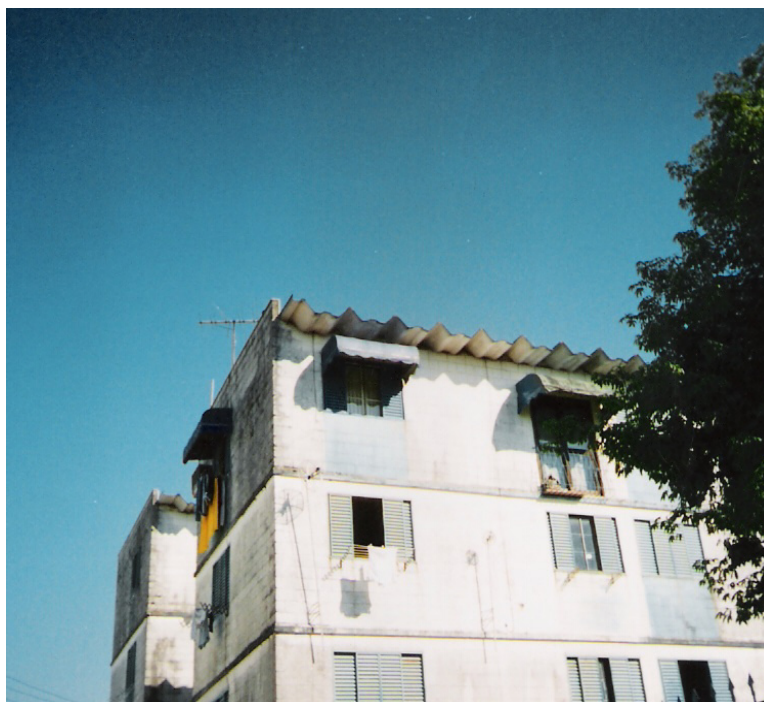
Figura 120 Exemplo de elementos de proteção solar, comum nos Blocos do Rubem Berta
