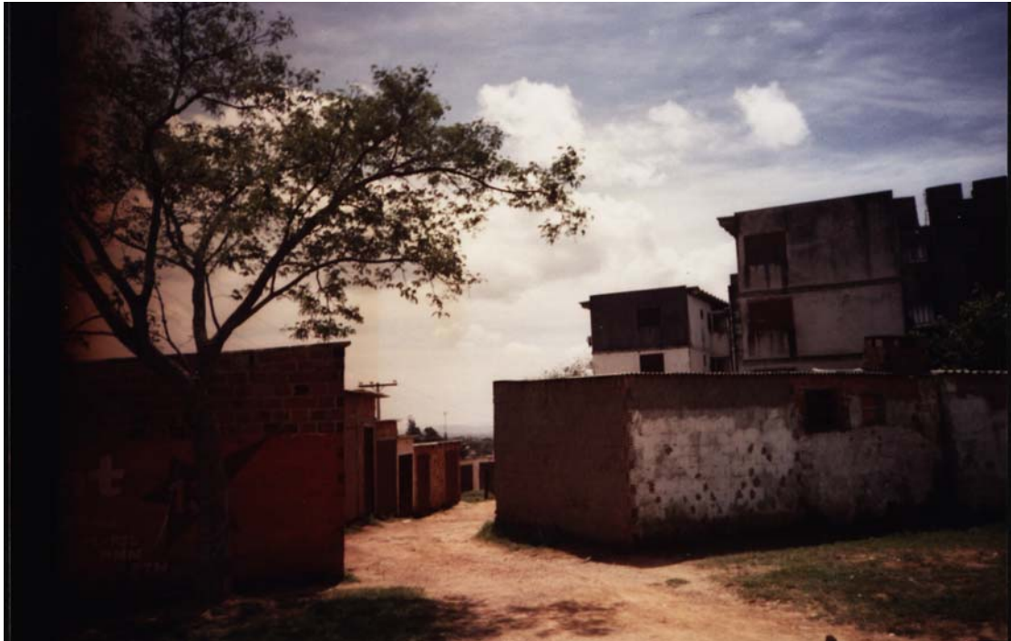
Figura 143 Entrada ao pátio de garagens
