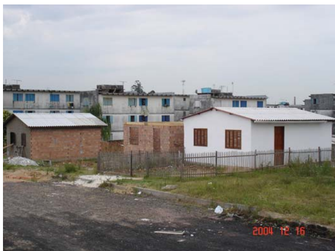
Figura 46 Casas PSH. Na implementação do projeto de regularização da COHAB Rubem Berta, famílias são removidas para casas construídas pelo programa PSH, em outras áreas livres do conjunto.
