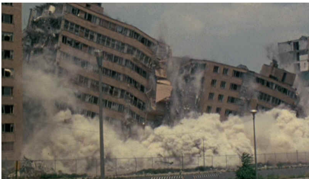
Figura 2 Implosão do conjunto habitacional Pruitt-Igoe, Saint Louis, EUA. Fonte: < www.thegline.com >
