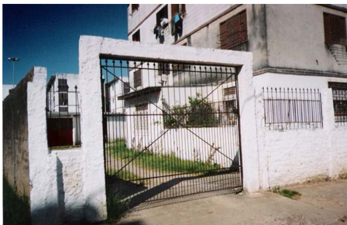
Figura 137 Exemplo de linhas limítrofes, muros com cercas
