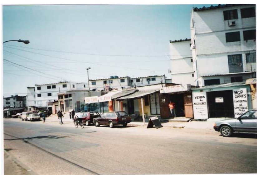
Figura 127 Células elementares transformadas em lojas, ao longo da Av. Adelino Ferreira Jardim
