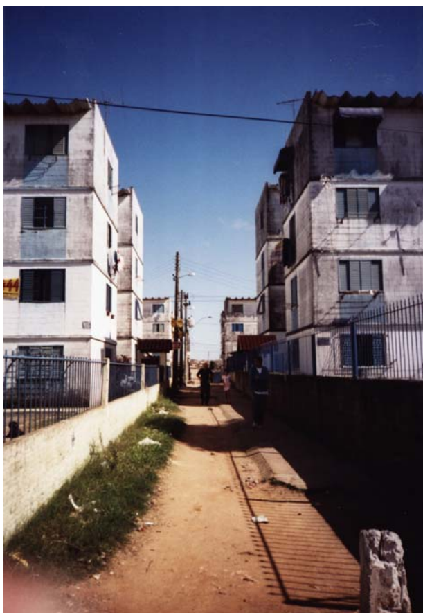
Figura 136 Exemplo de linhas limítrofes, muros com cercas
