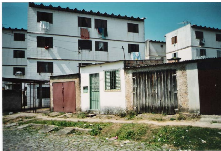
Figura 124 Exemplos de célula elementar: algumas permanecem como uso de garagem. Ao centro, em branco com esquadrias verdes, garagem transformada em residência
