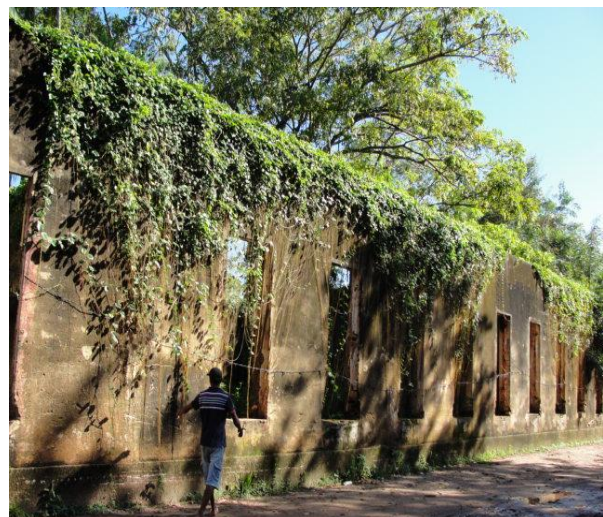
Figura 26: Ruínas da fachada do antigo Educandário Nogueira de Faria. Fonte: Foto: ZATREPALEK, P., junho 2011.
