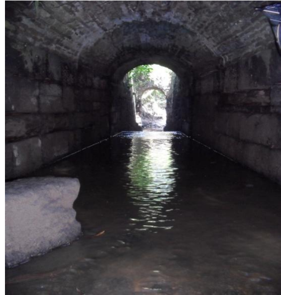
Figura 23: interior do antigo Engenho. Fonte: Foto: CANTO. A., junho de 2011.
