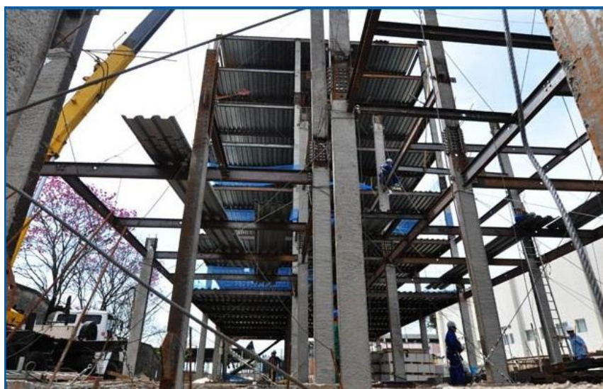
Figura 3 – Execução de pilares mistos parcialmente revestidos
