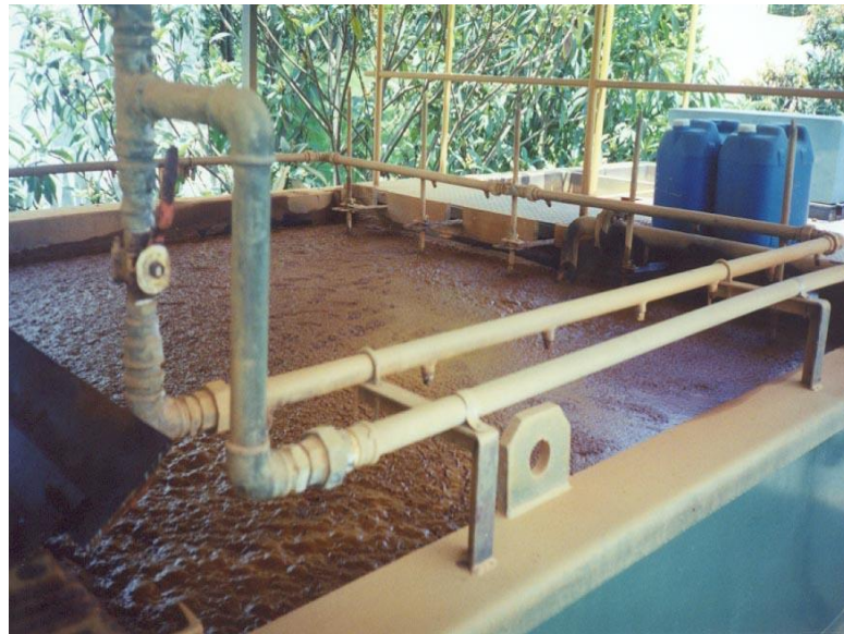
Figura 14. Unidade de flotação mostrando a camada de lodo flotado, ETA Mairiporã da Sabesp (Fonte: Centroprojekt do Brasil).
