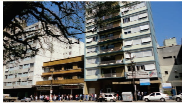
Figura 03 - Vista Área de Intervenção e Prédio CEU
