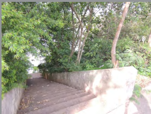
Escada para acesso ao rio - antigamente utilizada para passeios de barco
