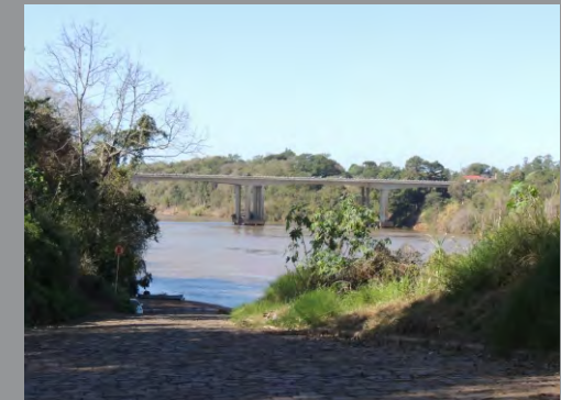
Rampa para acesso rio - barcos
