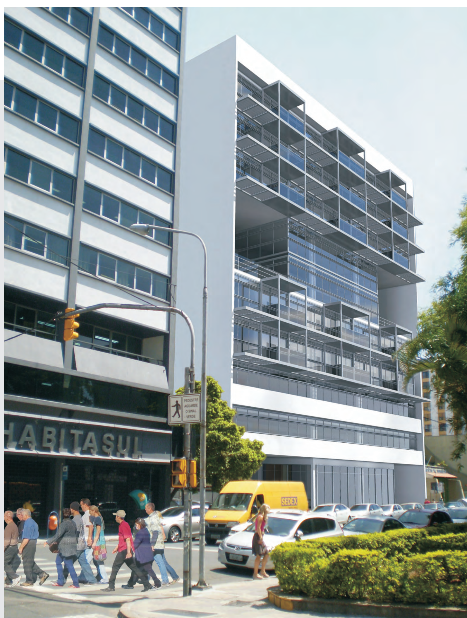
VISTA 6 | FACHADA NORTE RUA SIQUEIRA CAMPOS
