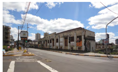
Vista da fachada principal
