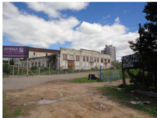
Face posterior do terreno com fachada existente
