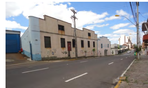
Edificações do entorno
