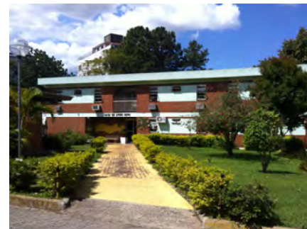
Casa de Apoio
