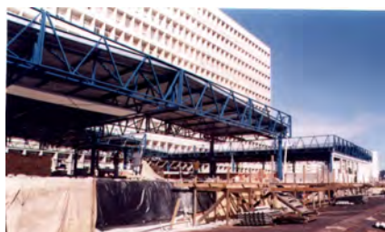
Serviço de Oncologia Pediátrica do HCPA, imagem obra.
