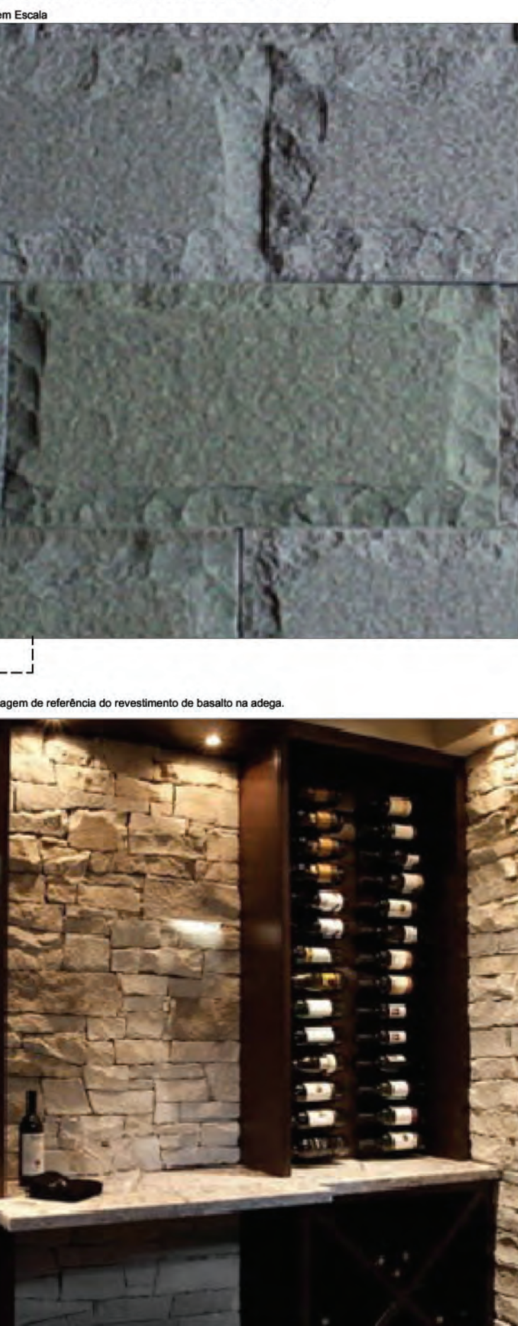
Detalhe do revestimento de basalto Sem Escala
