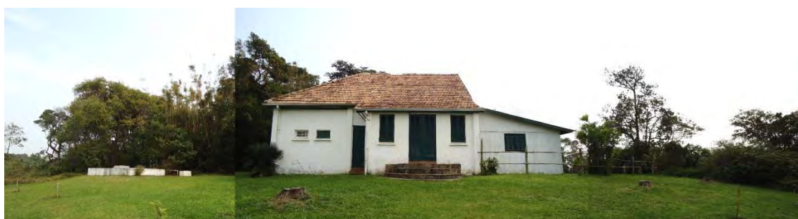
Área 2 - edificação a ser preservada
