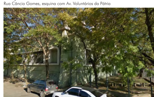
ESTAÇÃO DE BOMBAMENTO DMAE Rua Cândia Gomes, esquina com Av. Voluntários da Pátria
