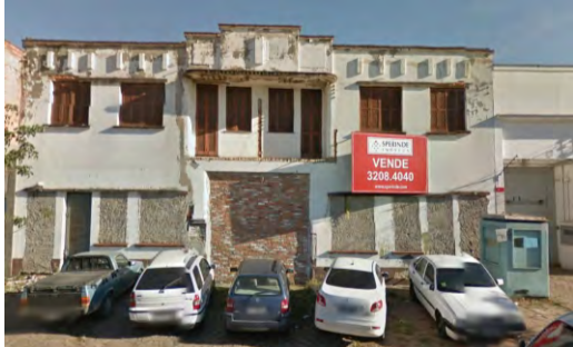
ANTIGO ARMAZÉM Rua Cândia Gomes, 213
