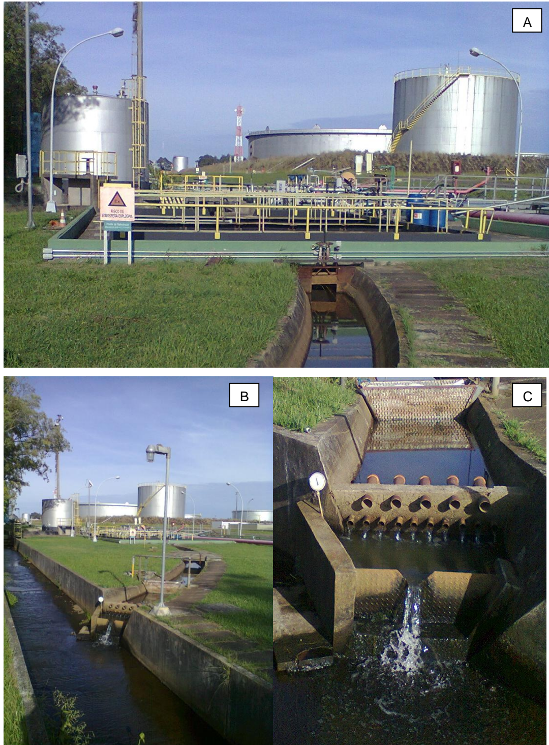
Fotografia 2 – Imagem do Separador de Água e Óleo do TEDUT: A - Sistema de piscinas de separação água/óleo; B – Saída do efluente para a Lagoa do Armazém; C - Vertedouro. Fonte: O autor, 2013.
