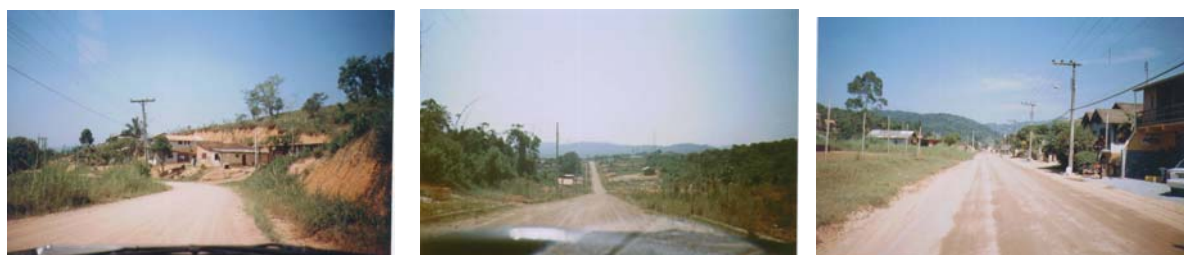
Figuras 3.29: O bairro mostra-se precário na sua infra-estrutura em toda a sua extensão
