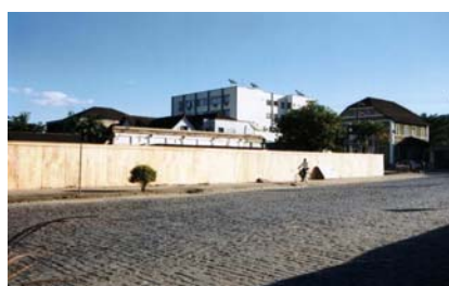
Figura 3.14: Construção do Terminal (2005)
