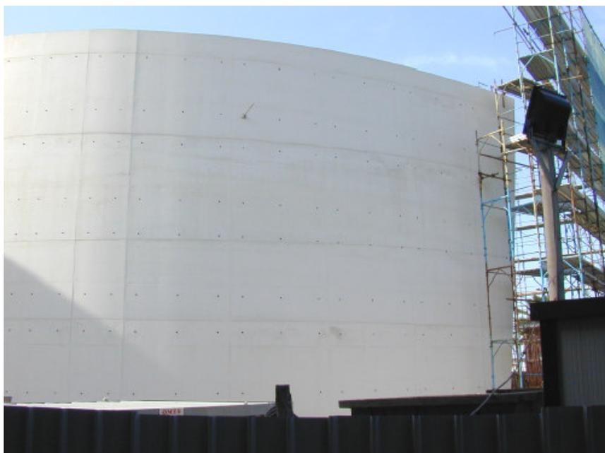
Figura 10: vista de uma parede em CAA branco – Pescara/Itália (fonte: Collepardi, 2001)
