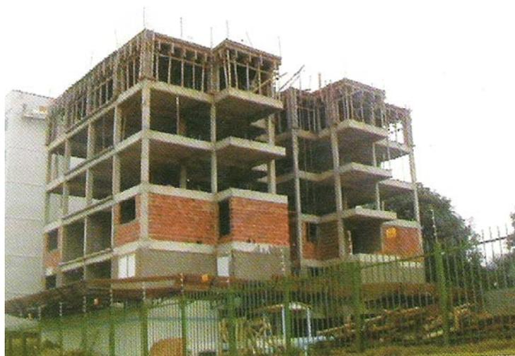
Figura 13: vista geral de edifício executado em CAA em Goiânia (fonte: REALMIX, 2005)
