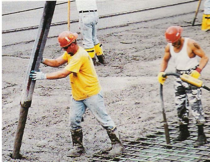
Figura 2: atividades de lançamento e de vibração do concreto (fonte: Kosmatka et al, 2002)
