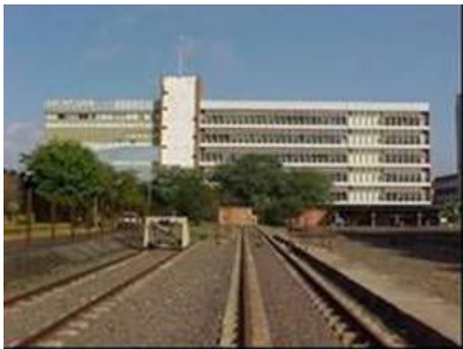
Figura 1: Vista do Prédio Administrativo da Trensurb (Fonte: www.trensurb.com.br ).
