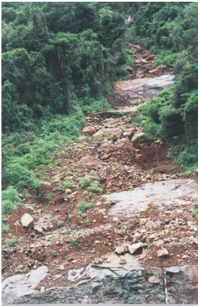
Figura 10 - Escorregamento de depósitos gravitacionais de encosta com grande extensão a montante km 43+150 a 43+210 da RS 122 (Azambuja et al. , 2001).
