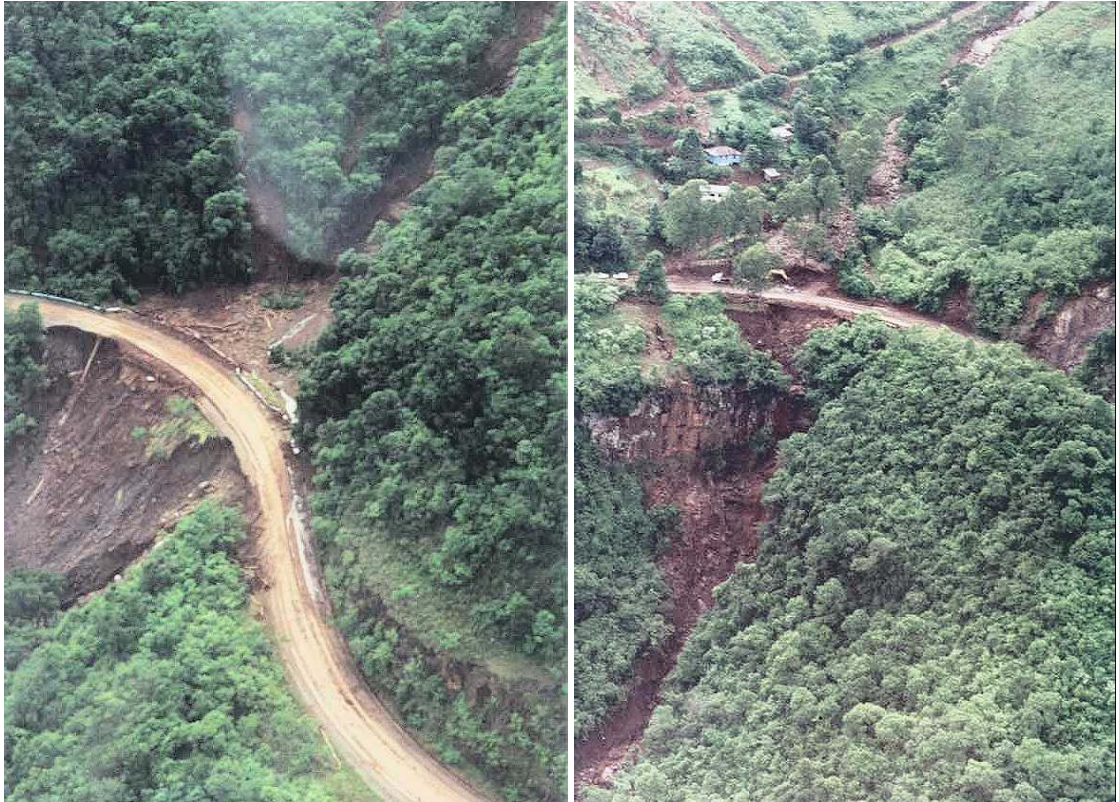
Figura 11 - Fluxos de detritos entre os km 44+460 a 44+600 e entre os km 45+300 a 45+360 da RS 122 (Azambuja et al. , 2001).
