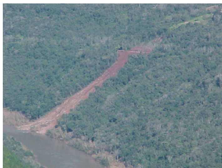
Figura 2 – Deslizamento de grande extensão, com aproximadamente 400 m, cruzando a RS 470, Trecho Bento Gonçalves-Veranópolis.
