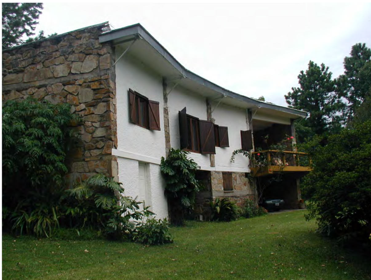
Fig. 1: Casa Ahualli, fachada norte.
