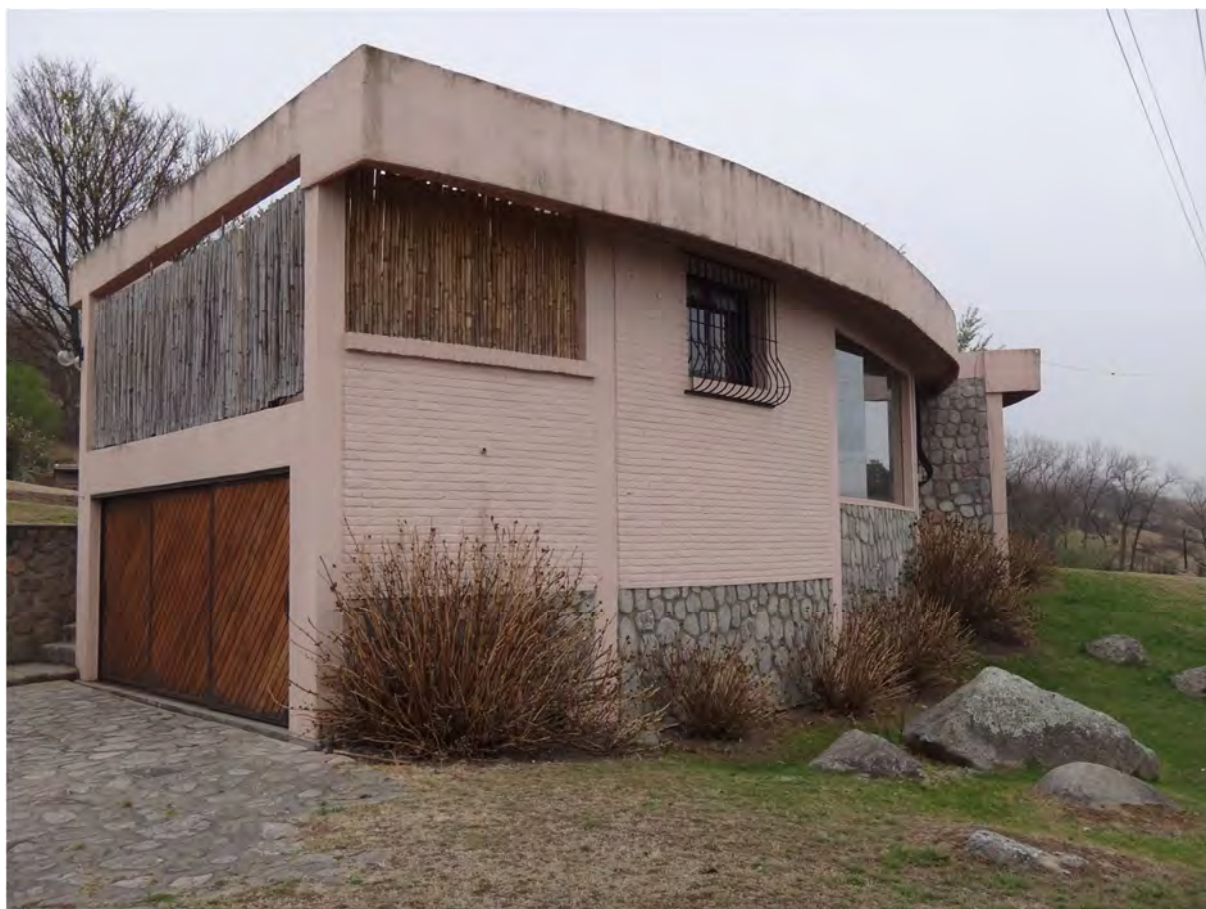
Fig. 1: Casa Benito, fachada sul-oeste.
