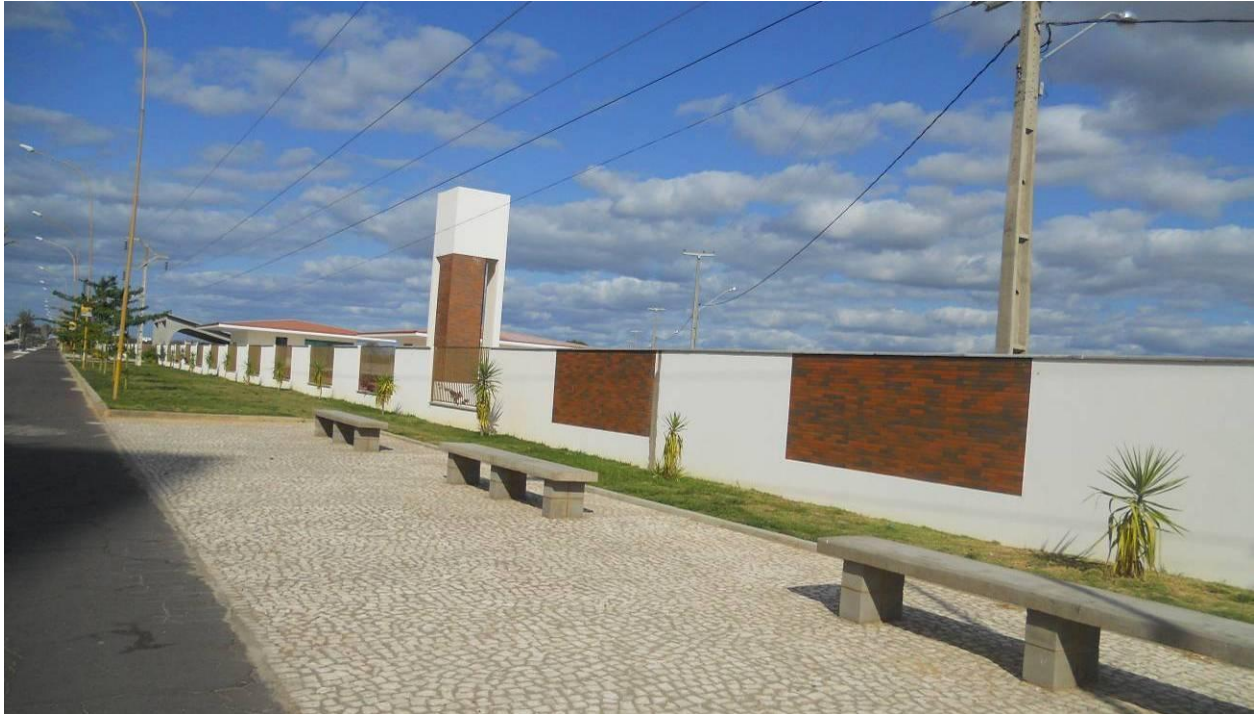
FIGURAS 21 e 22: Barreiras no acesso ao rio: muro do Gran Ville (acima) e cerca na gleba da família Coelho (abaixo)
