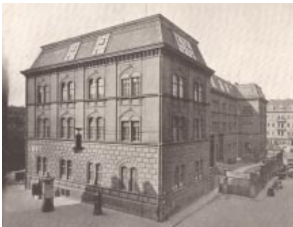
Fig. 5 - Casa da Anton'splatz, antigas acomodações do Polytechnikum.
