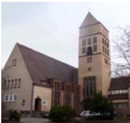
Fig. 16 – Igreja dos Apóstolos (Apostelkirche) e Casa Comunitária, Oswin Hempel, Dresden - Trachau, 1927.
