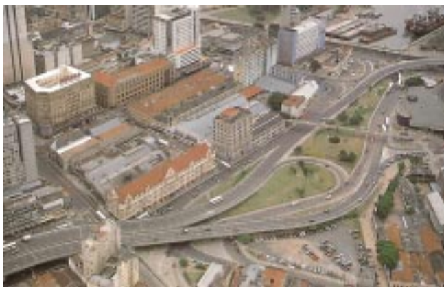
Fig. 1 – Vista aérea do centro com Elevado da Conceição e as lojas Mesbla de Porto Alegre e mais à frente o edifício Chaves também de Arnaldo Gladosch.
