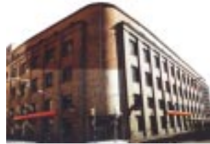
1944 – Edifício Mesbla Veículos, rua Cel. Vicente entre a rua Voluntários da Pátria e rua Com. Manoel Pereira, Porto Alegre/RS
