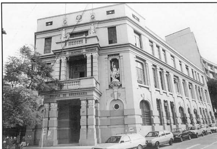
Prédio do Instituto de Eletrotécnica. Originalmente tinha dois pavimentos. O terceiro foi acrescentado na década de 50.
