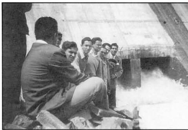
Visita (aula prática) à construção de uma barragem, 1950.
