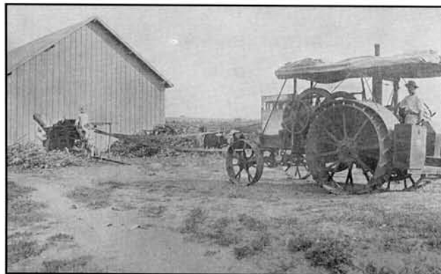
Máquina descascadora sendo acionada por um trator que foi montado no Instituto Técnico Profissional da própria Escola de Engenharia.
