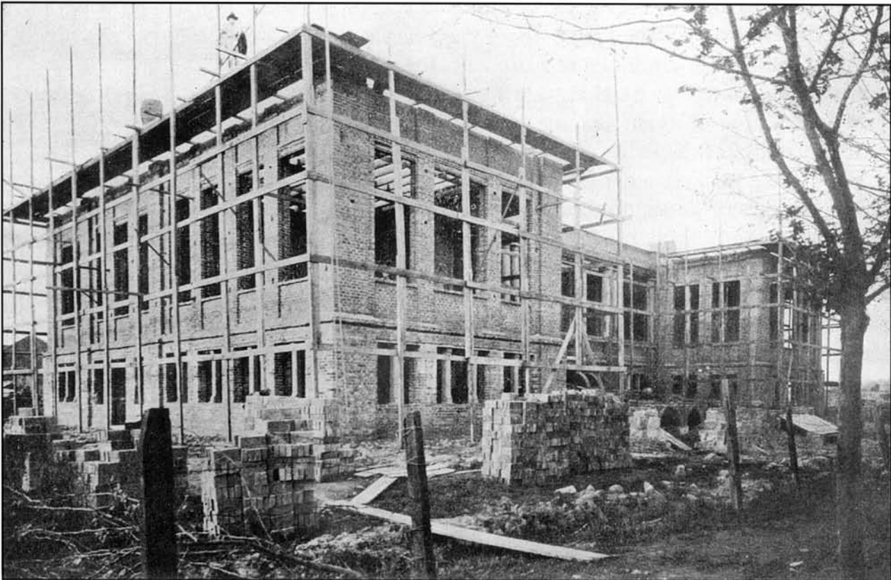
Prédio em construção (1922) para o curso de Química Industrial, ainda vinculado ao Instituto Montauray.
