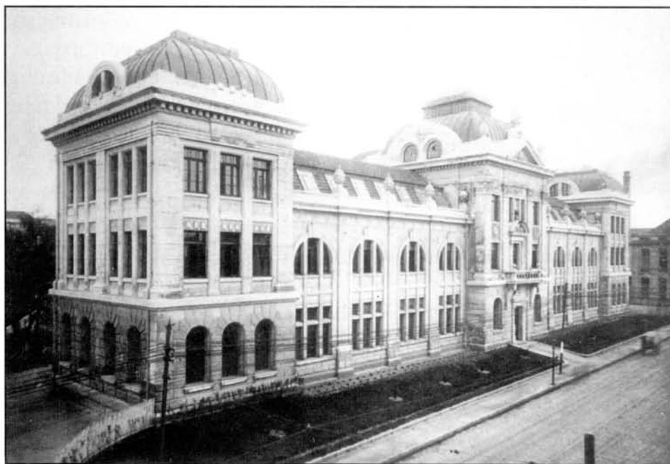
Prédio definitivo do Instituto Técnico-Profissional, mais tarde chamado Parobé.
