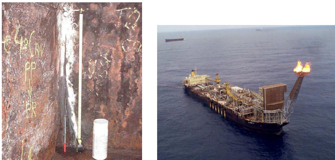
Figura 3.16 Trincas de corrosão-fadiga encontradas em tanques tipo FPSO (PIZA 2009).
