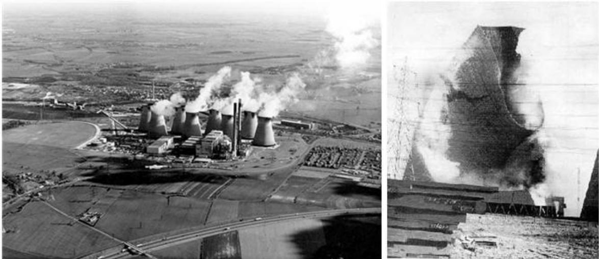
Figura 2 - Ferrybridge, Inglaterra (1965) - colapso de três das oito torres de resfriamento, atribuído aos efeitos da interferência de vizinhança entre as torres.
