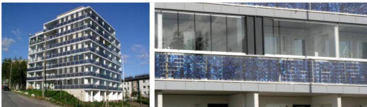
**Figura 3.13: Painéis fotovoltaicos integrados (TOLOSA, 2011).**
