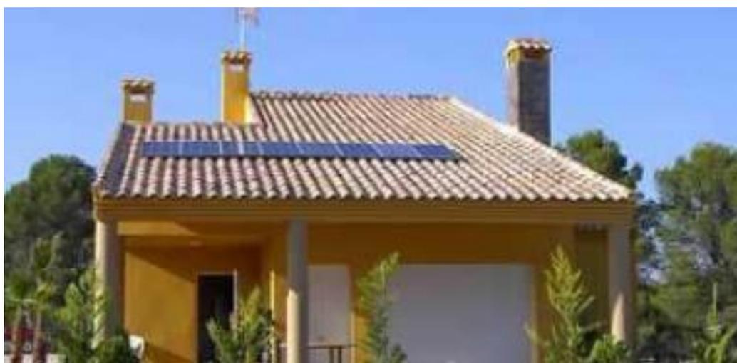
**Figura 3.12: Paineis fotovoltaicos sobrepostos (TOLOSA, 2011)**
