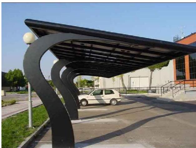
**Figura 3.14: Módulo fotovoltaico integrado como guarda-sol (TOLOSA, 2011).**
