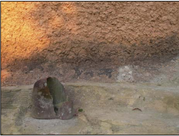
Figura 69 – Detalhe do barranco com obra.
