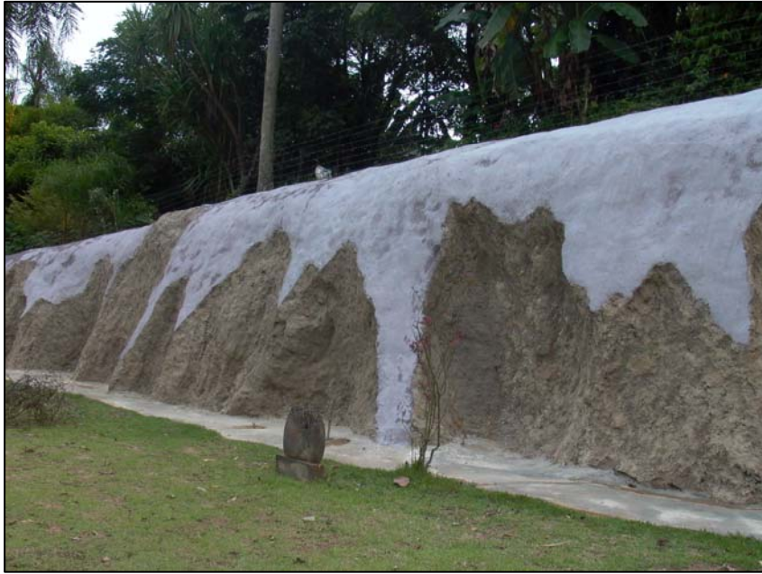
Figura 40: A materialidade sendo realizada. Obra n 1 da Ciranda de Arte.
