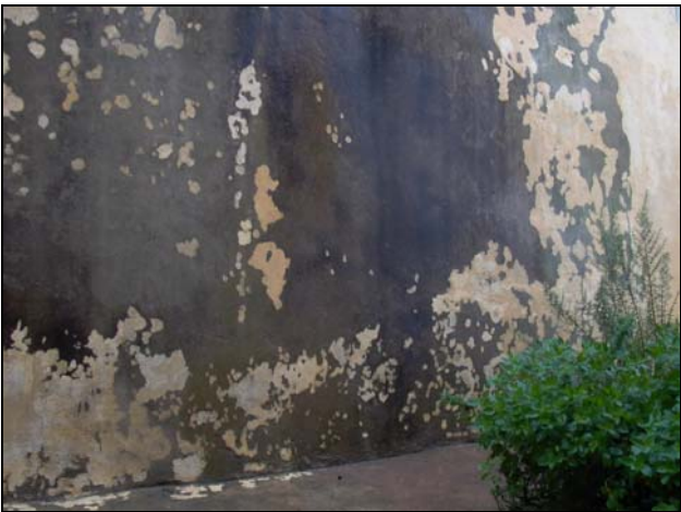
Figura 65 – Detalhe de um dos muros.
