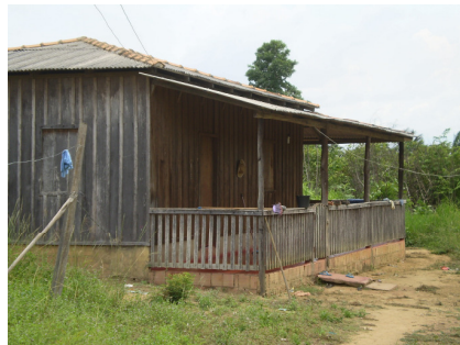
Habitação típica de madeira
