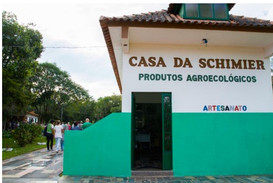
Figura 21 - Casa da Schmier. Fonte: pesquisa de campo realizada pela autora, 2013.
