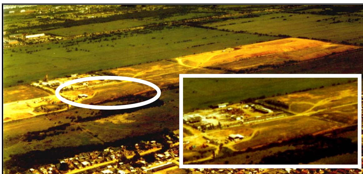
Figura 4.1 – Vista área do Aterro Sanitário Zona Norte, e Célula 4 no detalhe
