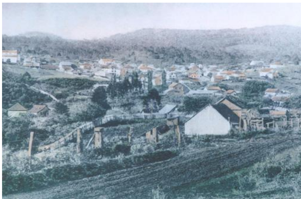
Figura 2 - Vista do Distrito de Capoeiras entre os anos 1918 a 1922.
